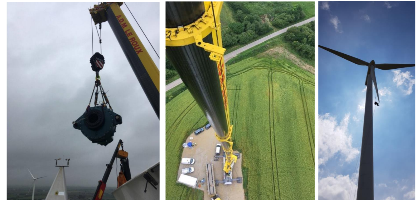
Photo 2 : Remplacement d'un multiplicateur – Parc éolien de Plondalmézeau (Source : ROMANDE ENERGIE)
