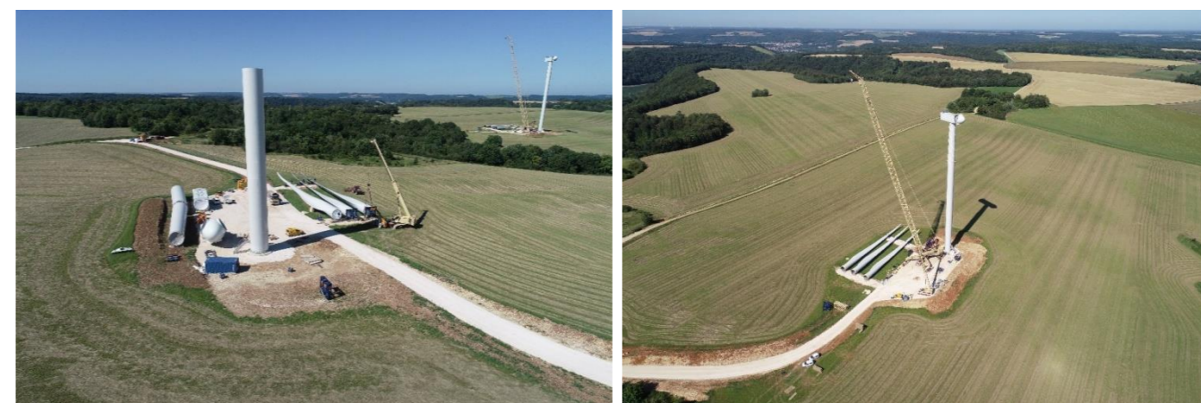
Photo 1 : Exemple de montage des éoliennes – Parc éolien de Piroy (Source : CALYCE DEVELOPPEMENT)
